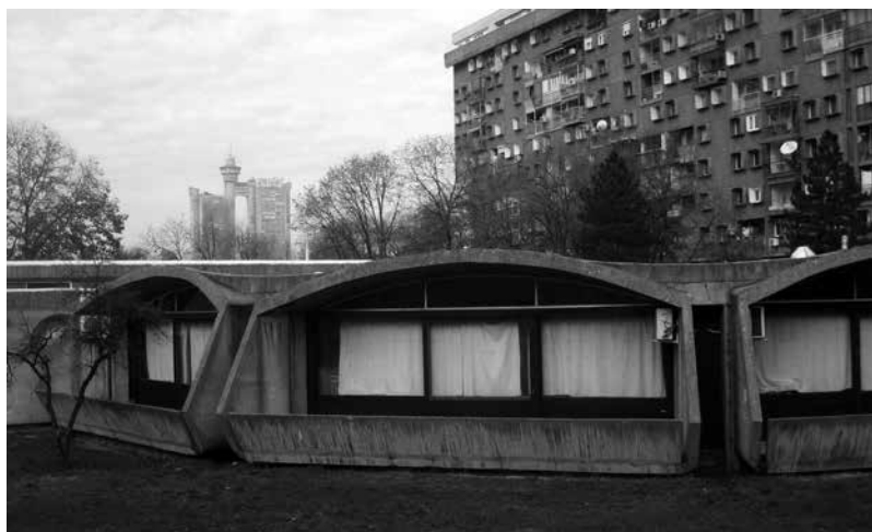
Slika 4. VVZ »Slavuj« v novobeograjskem stavbnem otoku 28 Foto: avtor prispevka, november 2014
