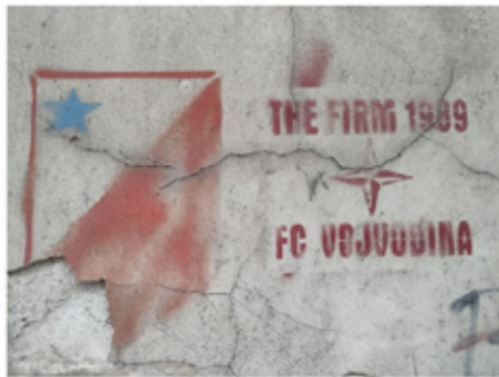
Прилој 9 (а–в). Београдска 12, Петроварадин: (9а) Табла изборне комисије (фото: А. Сајдл); (9б) Источни улаз у атријум (фото: А. Сајдл); (9в) Грб ФК Војводина на главној фасади (фото А. Сајдл)
