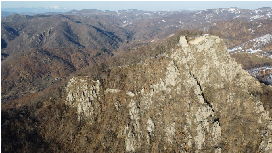
Сл. 1. Изглед утврђења снимљен са југозападне стране
