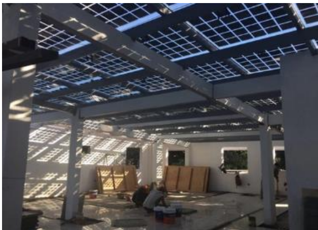
Слика 5. Полупрозрачни бифацијални фотонапонски панели интегрисани у објекту, [5]
