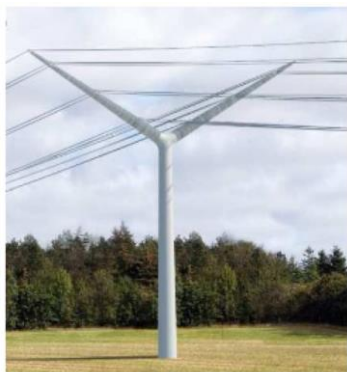
Слика 2. Далекководни стуб од изолационог материјала [7]
