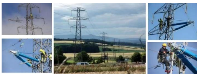
Слика 17. Реконструкција ДВ 132 kV и повећање напонског нивоа на 275 kV – Шкотска [17]
