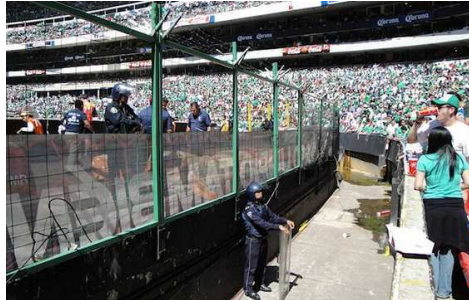
Slika 9. Ograda i betonski šanac između sportskog terena i gledališta.
